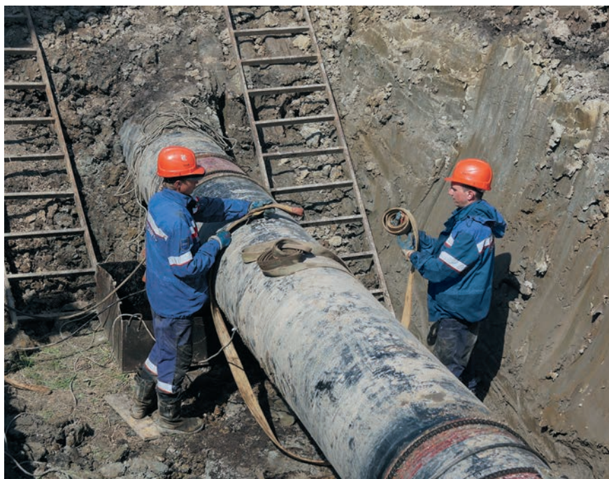
Чтобы смонтировать временную задвижку, необходимо для начала вырезать катушку
